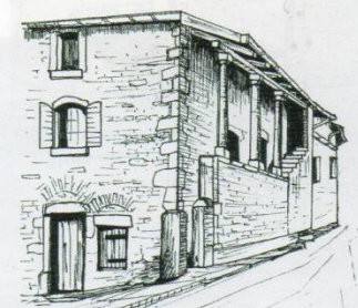
Maison vigneronne typique, avec son escalier extérieur en façade, protégé par un muret rampant et un avant-toit soutenu par des piliers de pierre dorée.
